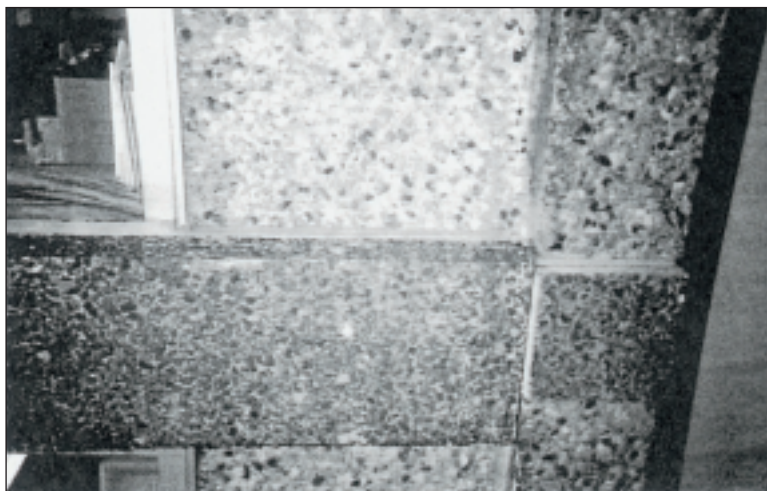
Utendørs fuge mellom elementer
